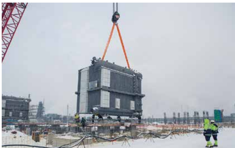
На ЭП-600 «Нижекамскнефтехима» устанавливают паровые котлы
